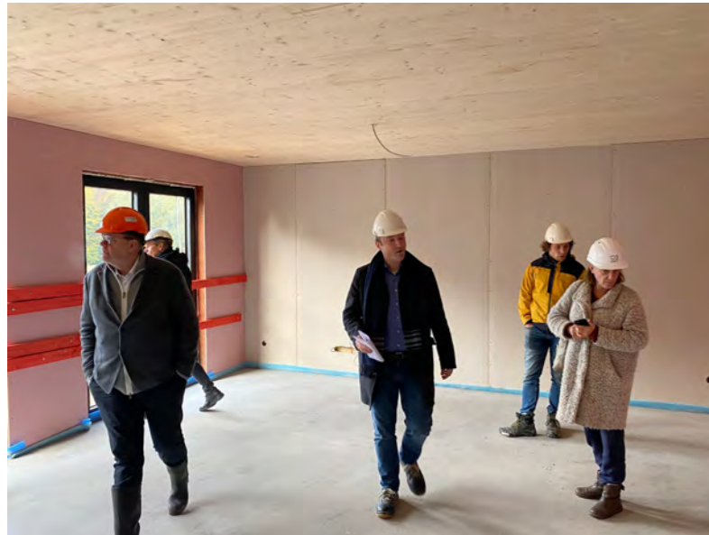
CLT in het zicht (plafond), wanden met gipsplaat
